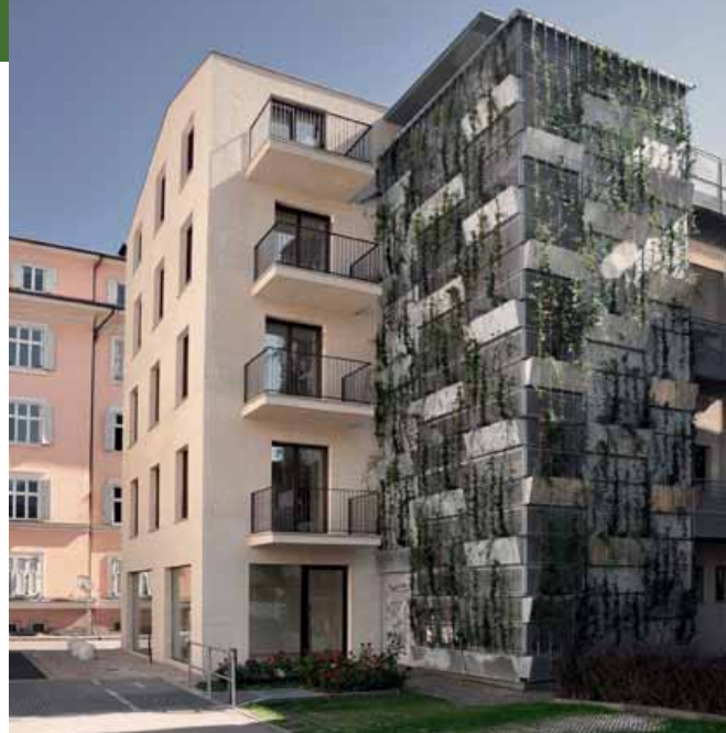
Verschönert: Der bestehende Stiegenturm musste erhalten bleiben, seine Lochblechfassade wurde aber durch üppig rankende Begrünung aufgewertet.
